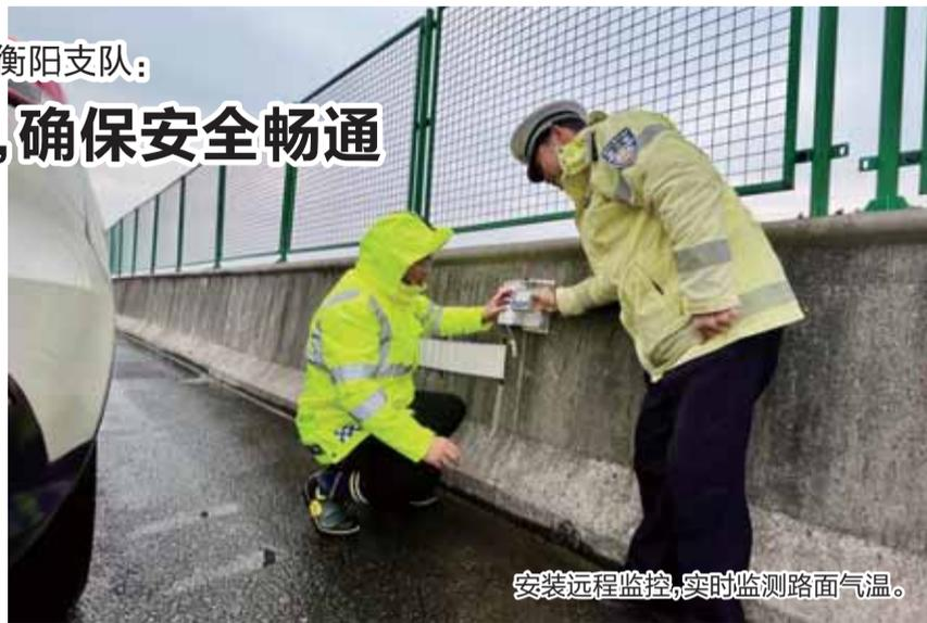
安装远程监控,实时监测路面气温。
