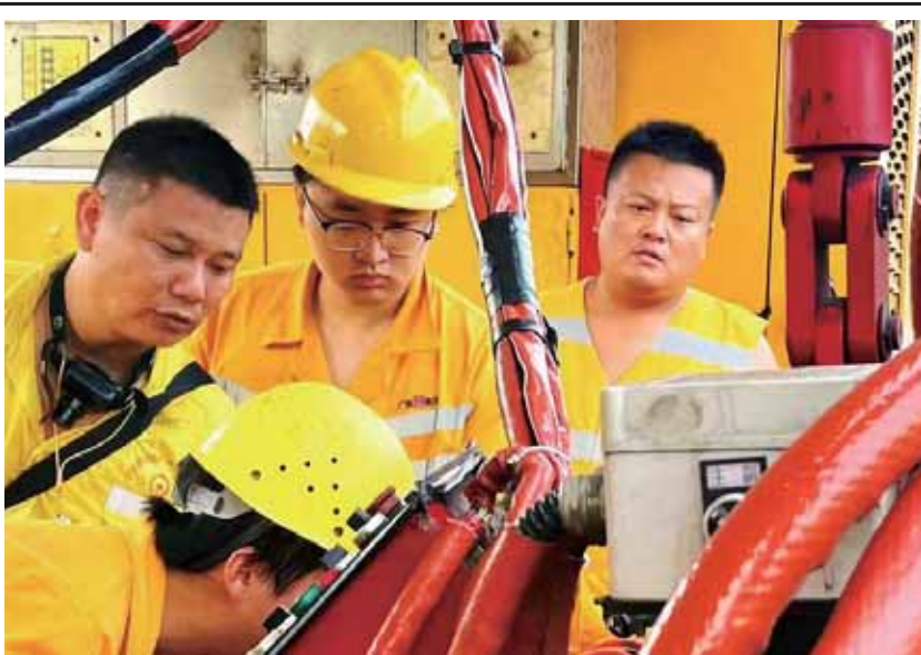
广州工务大修段衡阳焊轨车间以秋检秋鉴为抓手，组织精兵强将对车间所有焊轨机械设备、设施进行“体检”，全力消除安全隐患。
