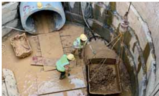
雨污分流改造工程项目现场。
