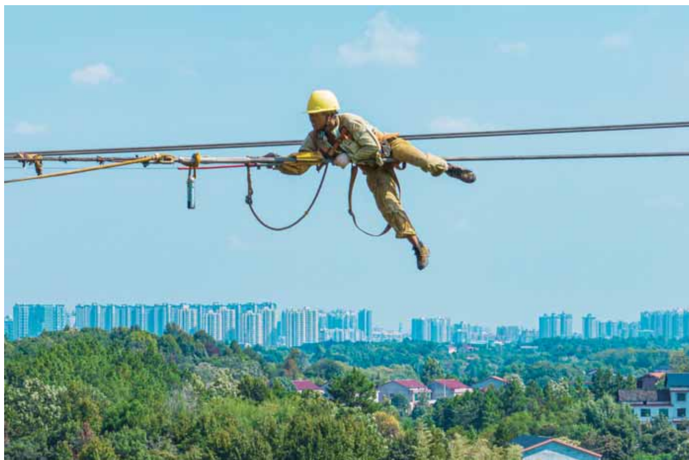
9 月 19 日,一名电力工人顶着烈日在蒸湘区雨母山镇七里山村架设高压线缆。据了解,2021—2022 年,衡阳市累计完成电网投资 38.1 亿元,排名全省第二,供电可靠性高居全省第一。 ■衡阳晚报全媒体记者 彭斌 摄
