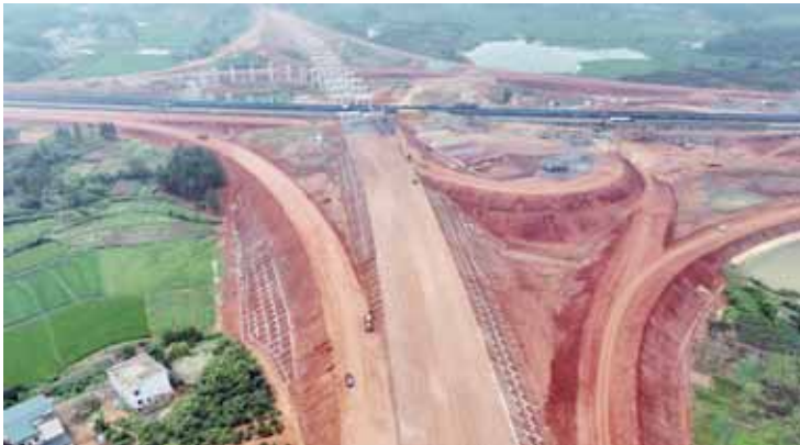
茶常高速公路96区试验段施工现场。
