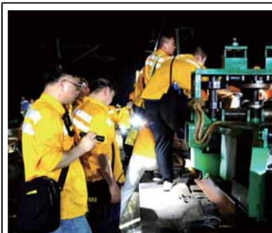
在贵广高铁一体化换轨施工战役中,广州工务大修段精心组织,周密部署,组织精干力量,克服气候炎热、施工照明光线暗等诸多困难,层层履职把关,施工安全生产有序推进。图为施工人员深夜现场盯控焊机作业。
