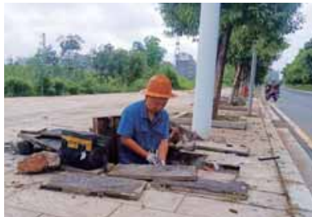
工作人员头顶烈日加紧排除线路故障。
