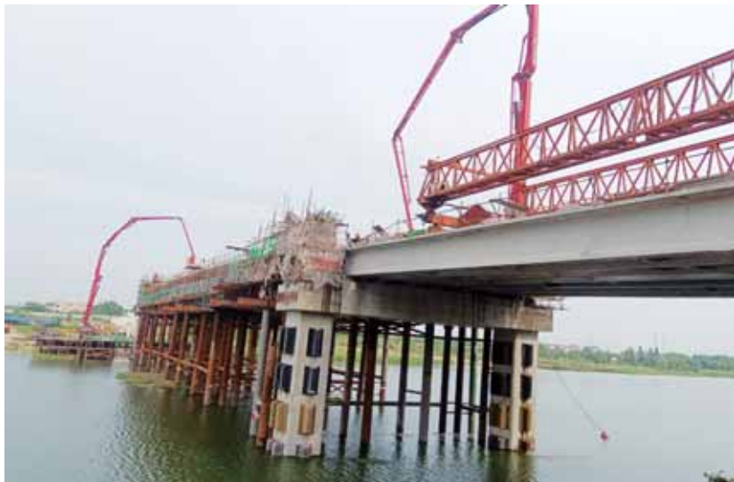
泉溪大桥施工现场。
