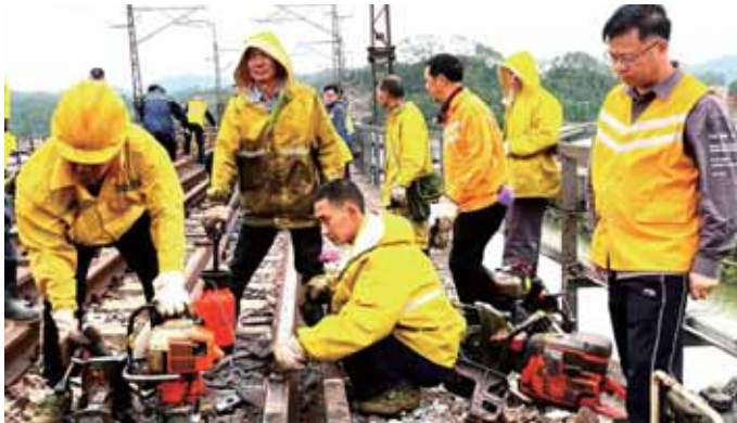
在京广线集中修施工战役中，广州工务大修段相关负责人深入现场，细化安全卡控措施，严格落实标准作业，确保了施工有序推进。 ■通讯员 陈志清 摄
