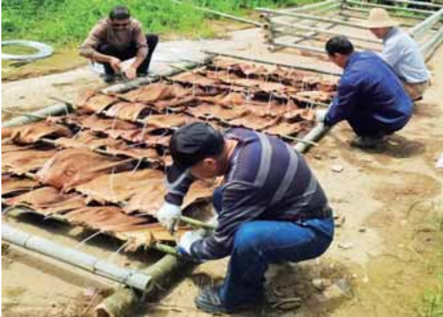
施工人员将棕榈片绑扎在竹篙框架上。
