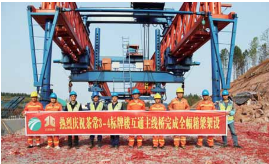
茶常高速公路牌楼互通主线桥最后一片预制梁安装就位。
