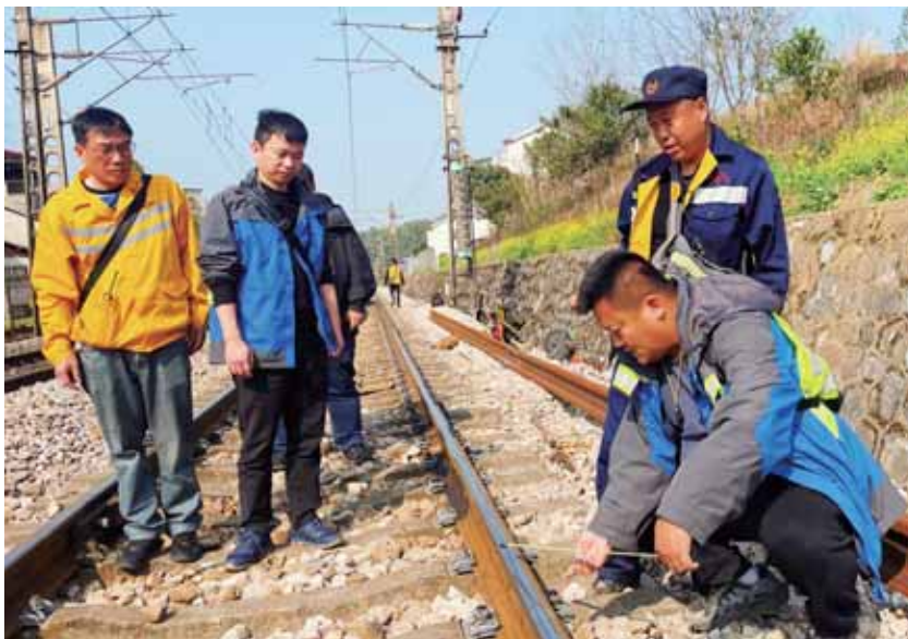
广州工务大修段衡阳焊轨车间不断优化生产组织和作业流程,精益求精,全力打造精品焊接工程。图为技术人员现场检查时的情景。■通讯员 陈志清 摄
