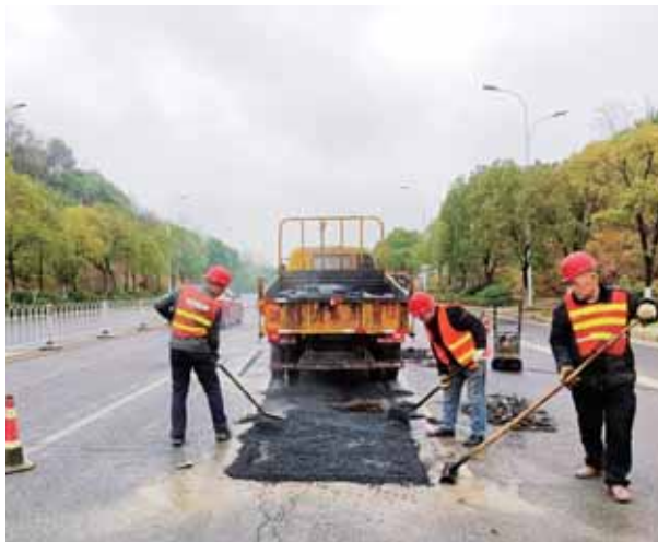
工作人员修补沥青路面。
