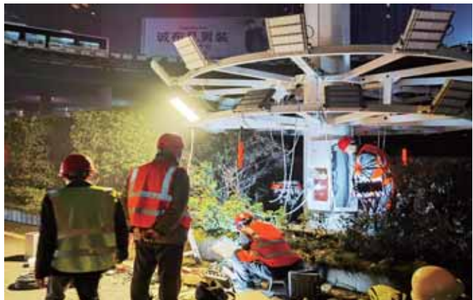
施工人员挑灯夜战,调试高杆灯升降设备。
