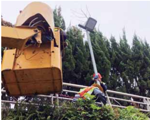
市路灯管理处工作人员加紧安装照明灯具。
