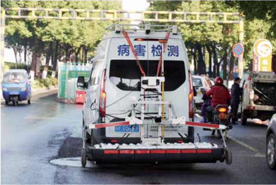
探地雷达车正在检测城市路面。
