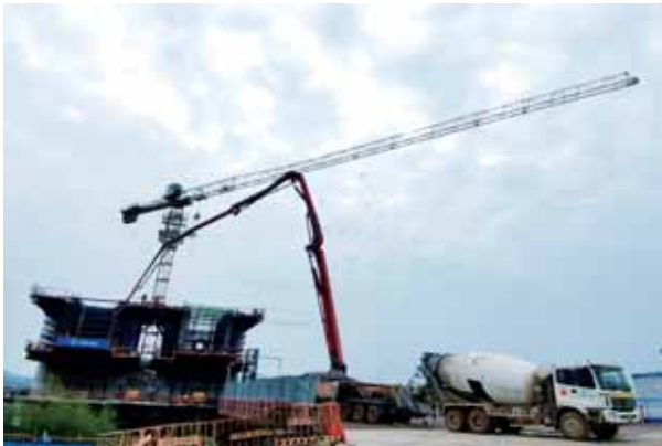
董家潭湘江特大桥建设现场。
