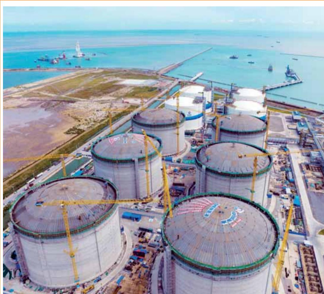
9月22日，中建电力建设有限公司承建的中海油盐城“绿能港”项目一期扩建工程10号储罐完成升顶任务，标志着整个项目所有储罐均顺利升顶，主体结构基本完成，建成后将成为国内规模最大的液化天然气储备基地。
