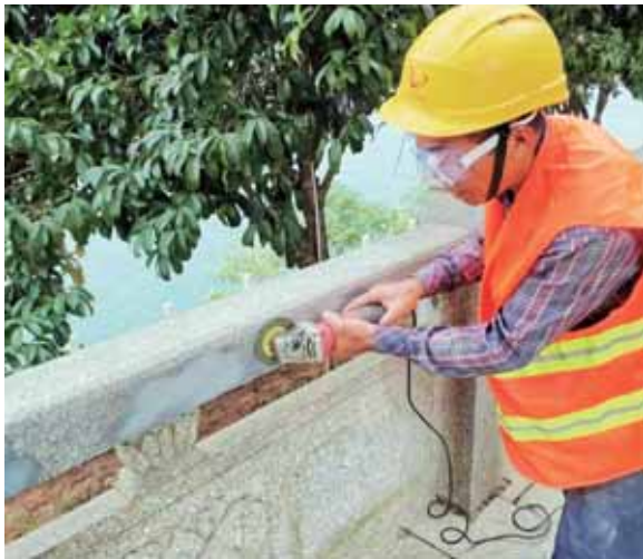
施工人员通过打磨、抛光，彻底清除护栏上碍眼的“涂鸦”。
