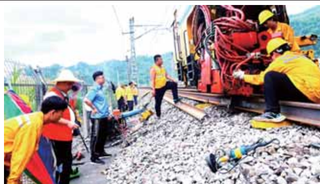
广州工务大修段在沪昆线第二阶段集中修攻坚战中,全体员工深入生产一线,段领导靠前指挥,克服了线路作业条件环境差、隧道多等诸多困难,齐心协力,攻坚克难,安全生产有力推进。图为焊机作业现场。 ■通讯员 陈志清 摄
