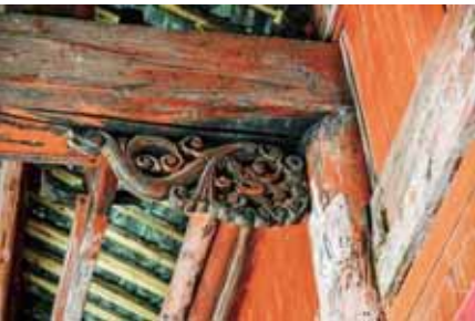
梁柱角处的雕龙构件。
