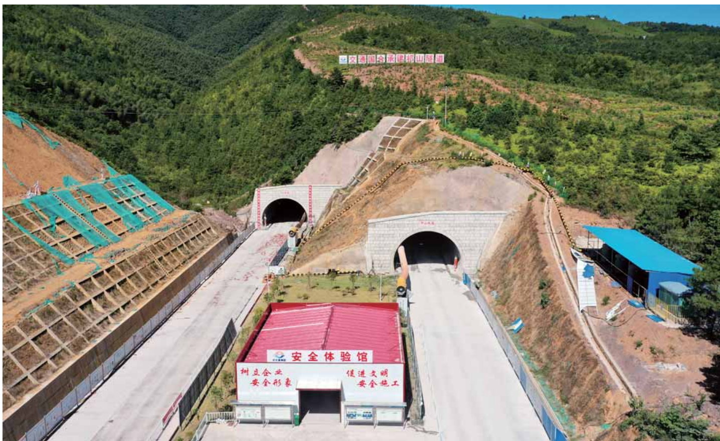
衡永高速公路祁山隧道左洞贯通。
