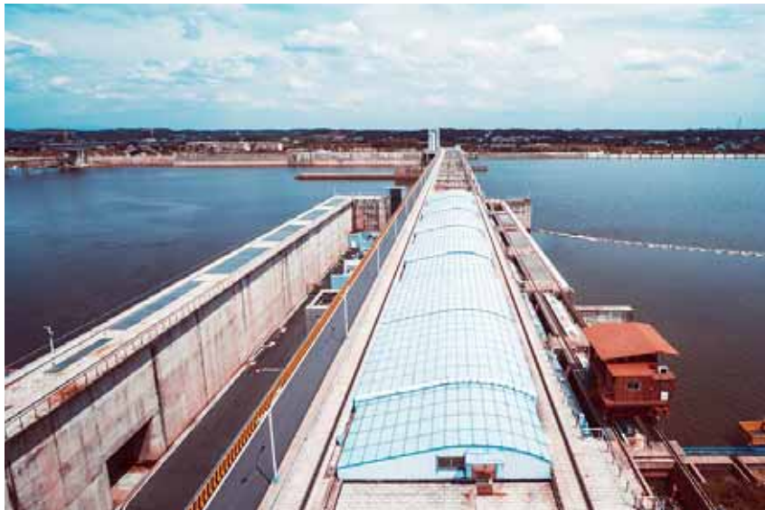
湘江土谷塘航电枢纽工程竣工验收顺利通过。
