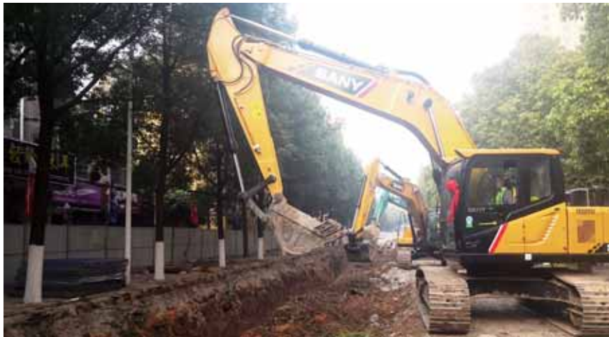
施工现场,挖掘机正在开挖沟渠。
