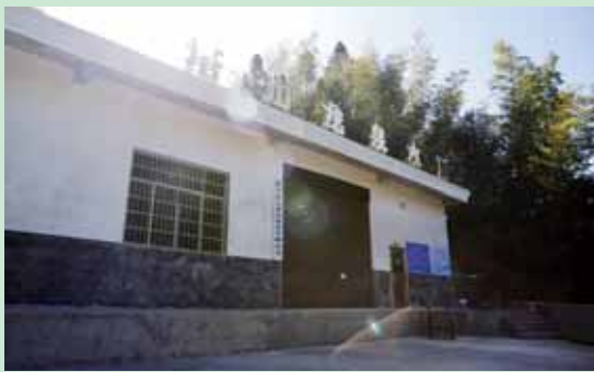
阳山村利用当地资源建设的纯净水厂。
