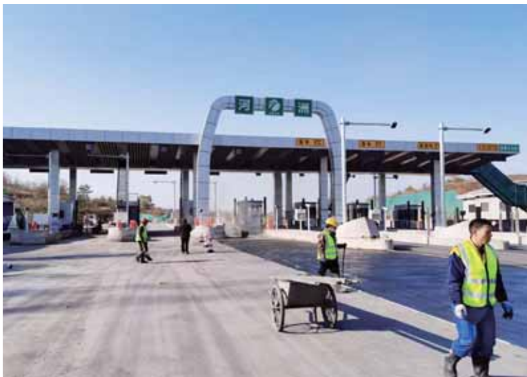
常祁高速河洲收费站施工现场。
