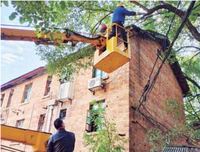
利用高空作业车及时清除树木高处的枯枝。
