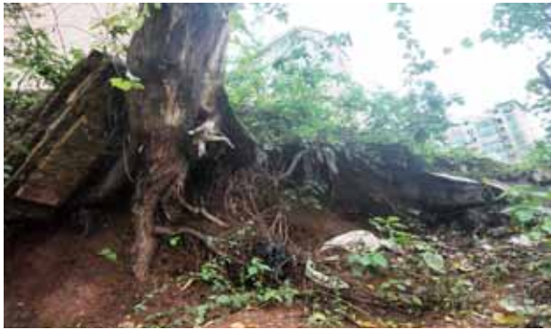
泥土被挖,树根裸露。
