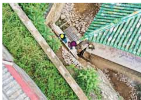
10月12日,工作人员在修缮太原市晋祠博物馆的护坡岩体。
