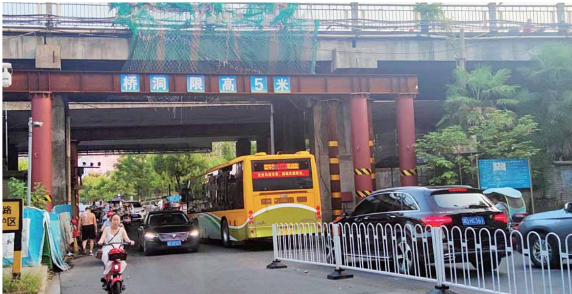
湘江公铁大桥道口段将安装防坠棚。
