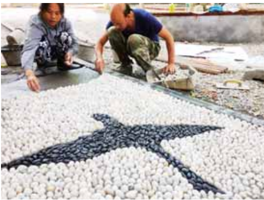
施工人员正加紧拼绣雨花石健身游步道。
