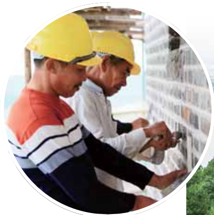
工人们正在脚手架上为塔体青砖勾缝。
