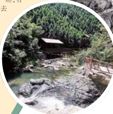
▲大瀑布下的小石潭,边上正在建设服务设施。
