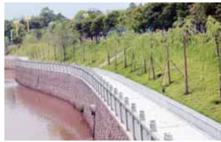
青花河堤砌护栏,胡法生出资又出工。
