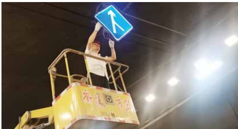
技术人员对供电线路开展全面排查检修。
