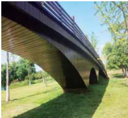
防腐木结构的拱桥古朴自然。
