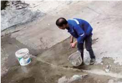
施工人员正加紧对雁影潭池底进行补漏处理。
