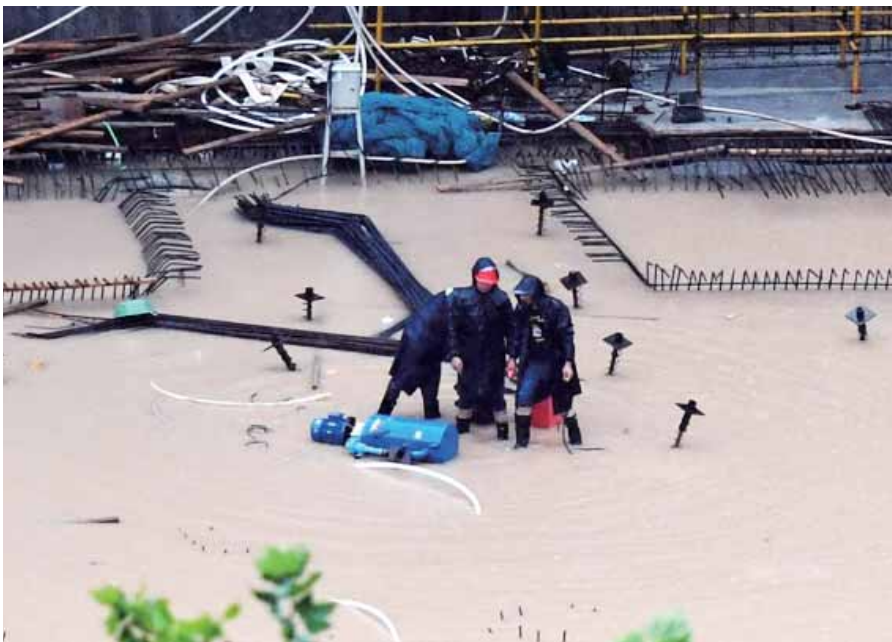
7月20日,工作人员在郑州市一建筑工地排水。
