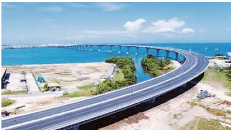
文莱大摩拉岛大桥。连接文莱摩拉区和海上摩拉岛的重要桥梁,其建成改写了大摩拉岛无桥梁连接文莱大陆的历史。
