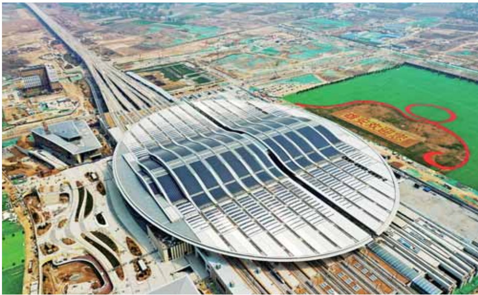
这是 4 月 9 日拍摄的京雄城际铁路雄安站(无人机照片)。■新华社发
