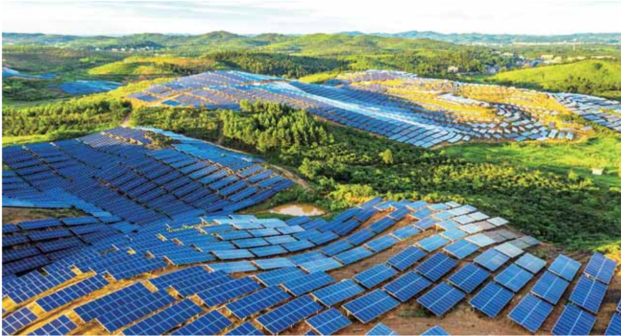
常宁市西岭镇小松柏村光伏发电场,夏季风光如画。小松柏村光伏发电场是“点亮”常宁集中式光伏扶贫电站重点项目,带动当地村民增收,促进乡村绿色发展和可持续发展。
