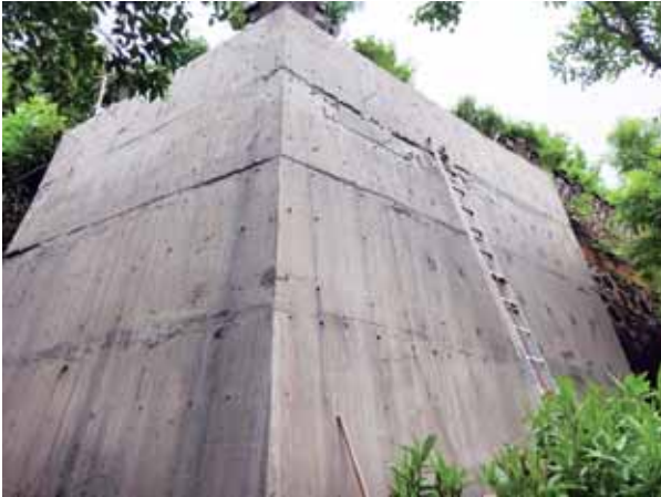
高约6米的护墙已浇筑成型
