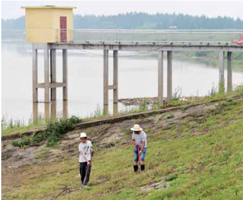
5月25日,在江西南昌县蒋巷镇赣江大堤,工作人员沿堤坝巡查排险。
