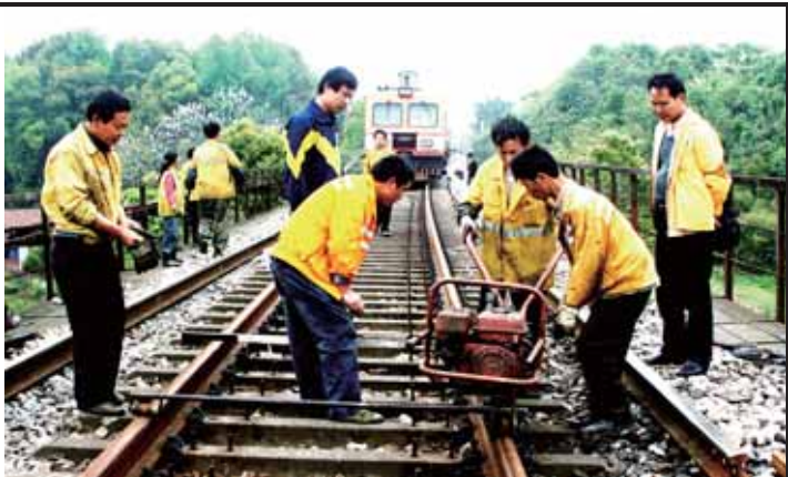
“五一”不休假,绷紧安全弦。广铁工务大修段优秀党务工作者、长沙换轨车间党总支书记周晓恒(右一),深入一线与职工一起检查施工作业安全。
