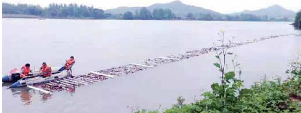
施工人员正加紧安装警示灯
