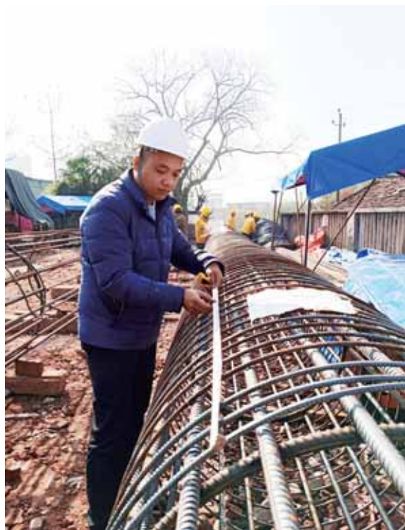
冯建华在测量钢筋笼箍筋间距
