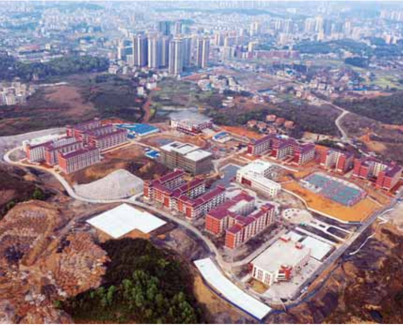
常宁市二中新校区各项建设如火如荼推进:体艺馆封顶工程正在扫尾中;高一年级教学楼、宿舍楼已投入使用;高二年级教学楼、体育馆、图书馆已进入二次装修,计划6月份完成;高三年级教学楼、宿舍、教师公寓、第二食堂已基本完成主体工程;综合楼主体已完工,计划7月份完成二次装修等工作。 ■通讯员 徐瑞东 摄
