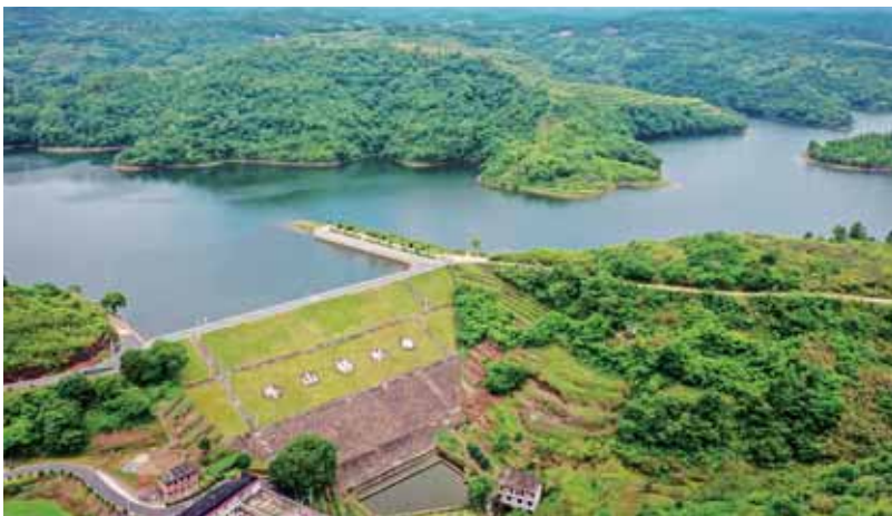
衡南县斗山桥水库
