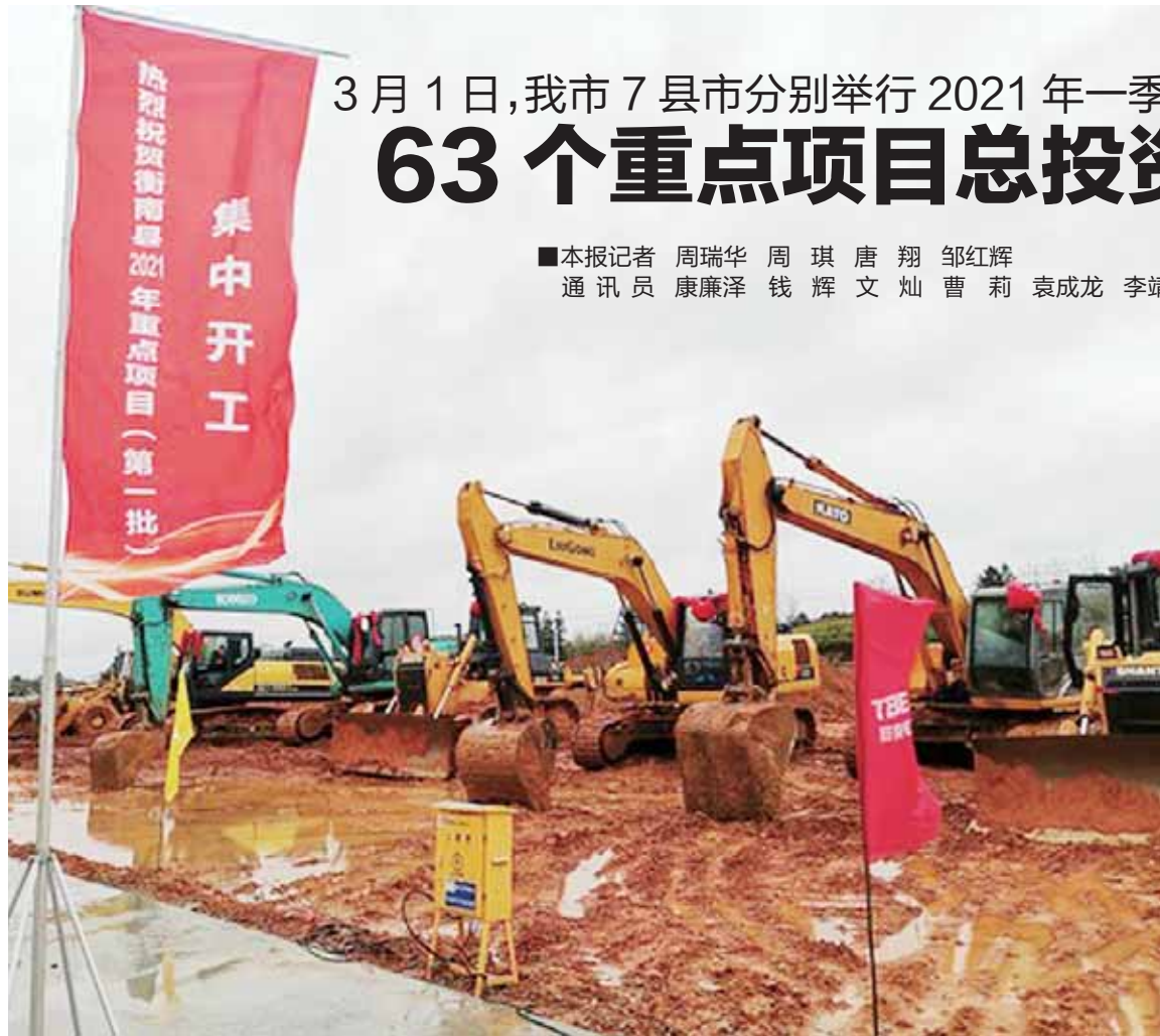
衡南县6个重点项目集中开工 ■周瑞华 摄
