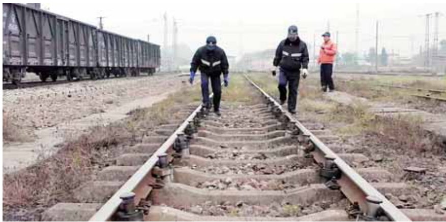
“减速哥”兵分两线对17道线路前端的双排减速顶进行脚踩测验
